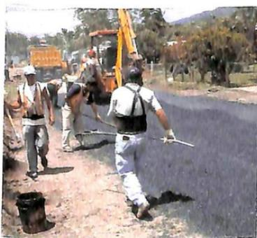
Figura 48. Bacheo y reparación de vías. Fuente: Archivo digital fotográfico. ACP.
