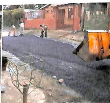
Figura 49. Bacheo y reparación de vías. Fuente: Archivo digital fotográfico. ACP.
